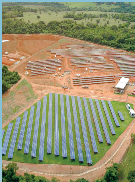
Usina fotovoltaica da Concebra em Goiás
