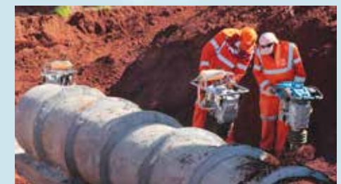
Acima, preparação do solo para camada de asfalto. Abaixo, instalação de sistema de drenagem
