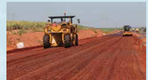
Acima, preparação do solo para camada de asfalto. Abaixo, instalação de sistema de drenagem
