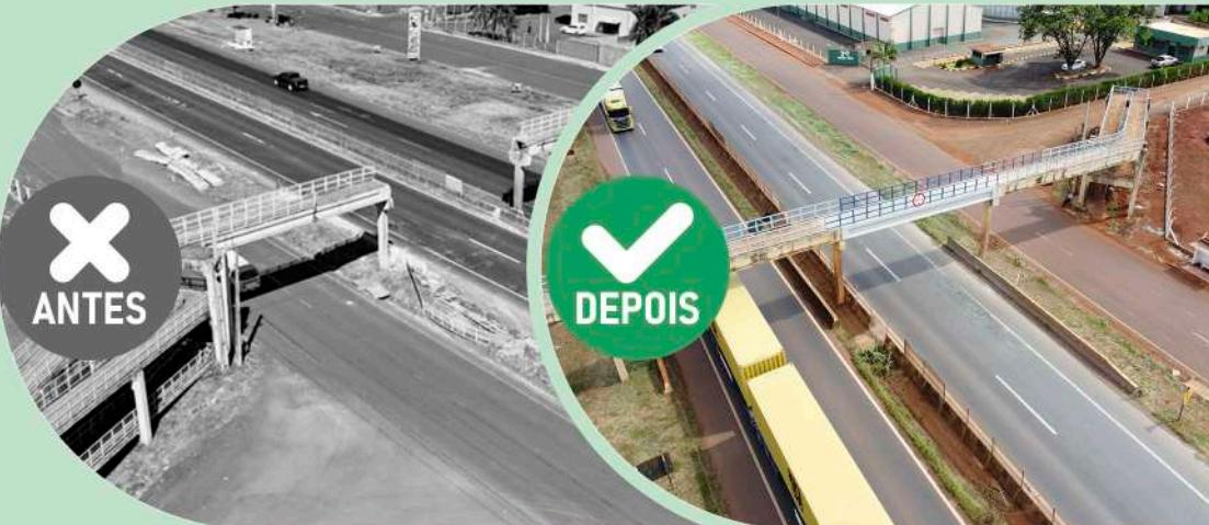
A Triunfo Concebra concluiu a obra de recuperação da Passarela de Pedestres, na BR-153, km 18+500, em Centralina/MG. A obra foi necessária em decorrência de acidente envolvendo uma carreta que transportava uma escavadeira e colidiu contra a estrutura da passarela de pedestres no local. Não houve vítimas
